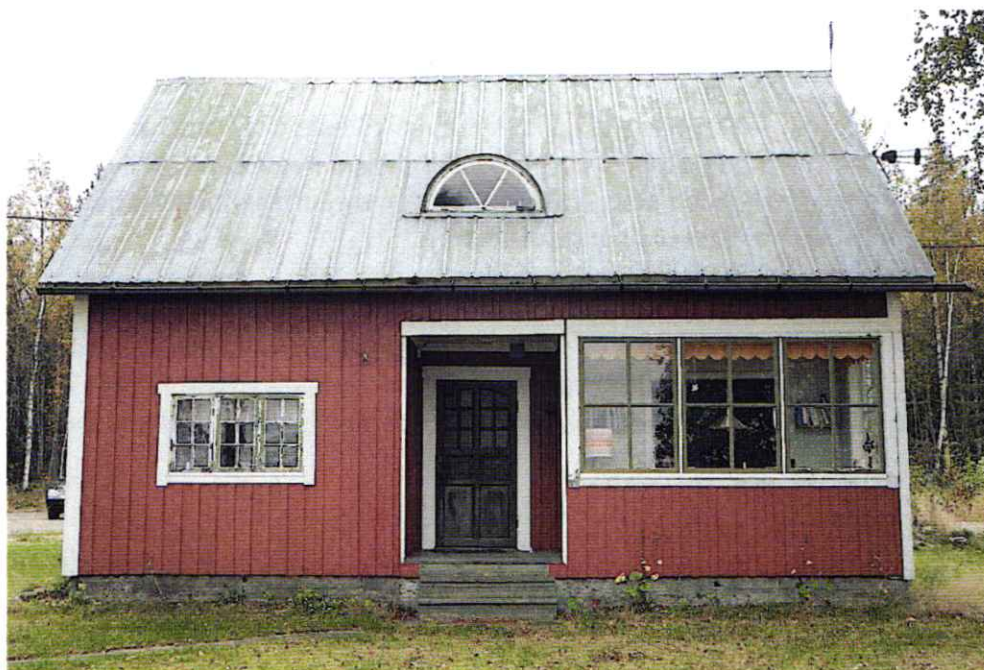
Äldre byggnad på Stöcke 12:11 Utdrag ur fotobilaga tillhörande muséets yttrande.
