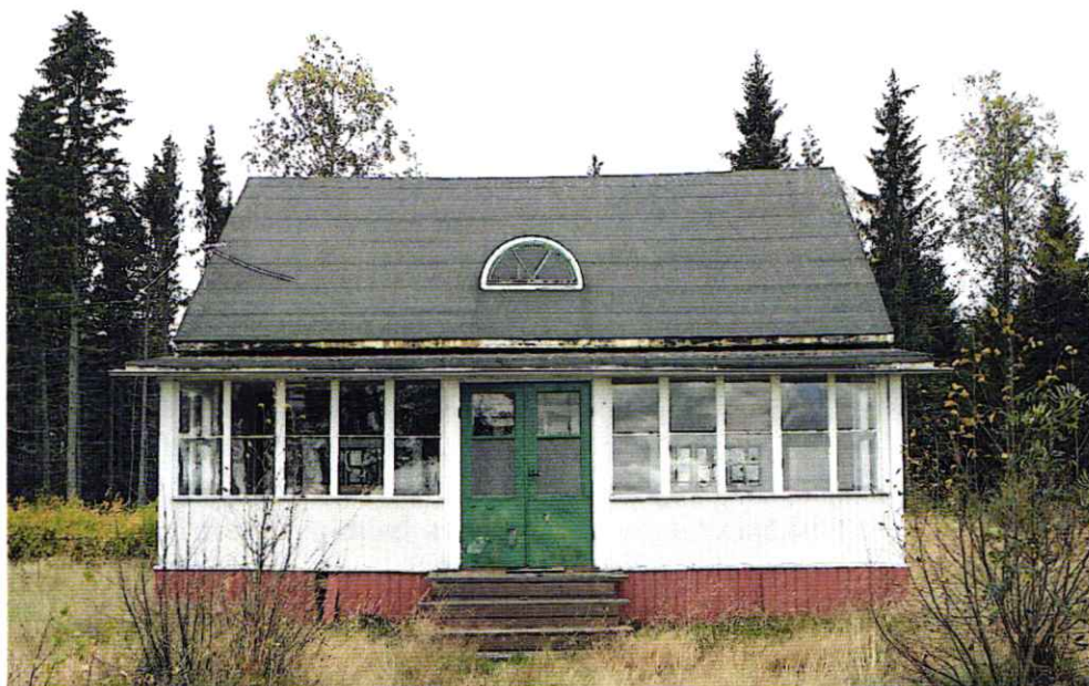
Äldre byggnad på Stöcke 12:10 Utdrag ur fotobilaga tillhörande muséets yttrande.
