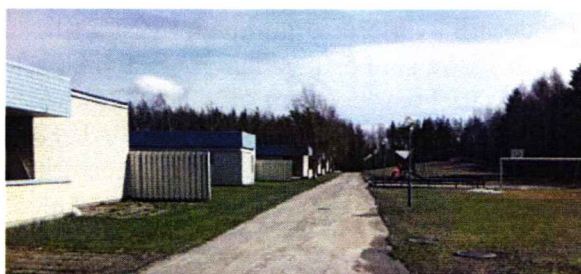
Befintlig bebyggelse på fastigheten Stadsliden 6:3.
