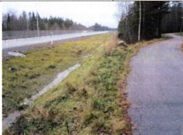
Figur 3. Dike vid väg E4.
