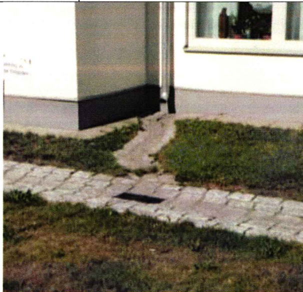
Figur 6. Utkastare med förstärkt infiltration.
