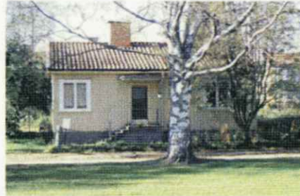
Utdrag ur Byggnadsordning för Haga – Sandbacka. Värdefull bebyggelsemiljö: Egnahem vid Östra Hagaparken, 40-tal. Rödmarkerat område – planområdet.
