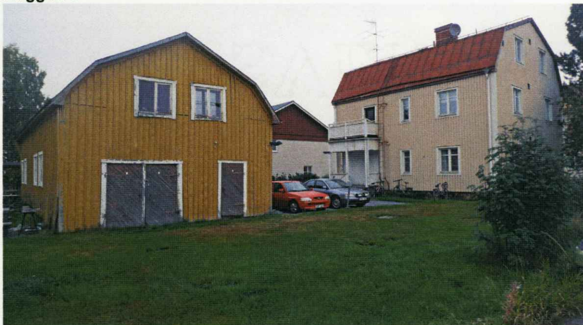
Fastigheten Flaggan 3. Till vänster: befintligt gårdshus som avses ersättas.
