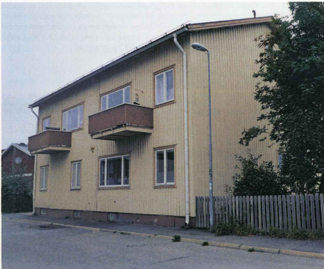
Huvudbyggnad inom Svärdet 12 sedd från Södra Majorsgatan.
