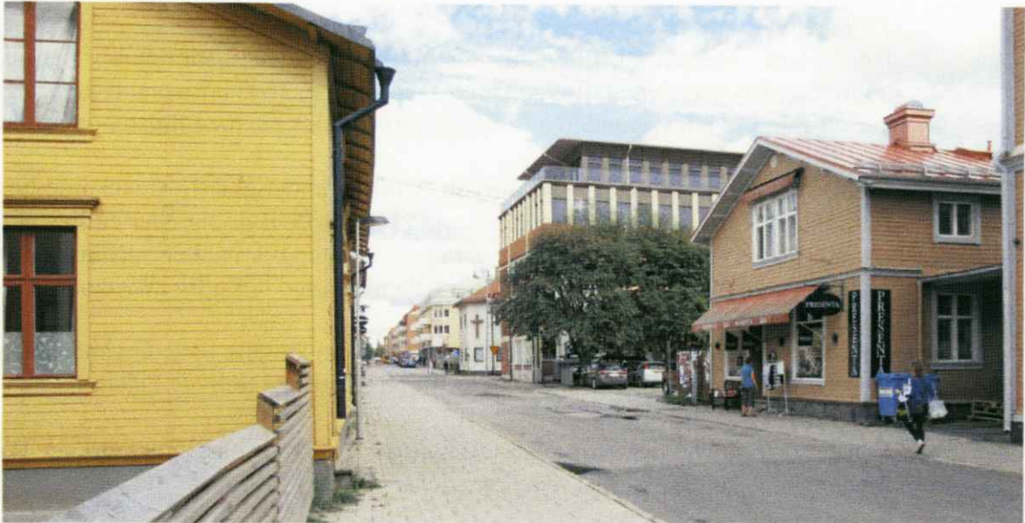
Vy längs Sveagatan mot det på- och tillbyggda huset.
