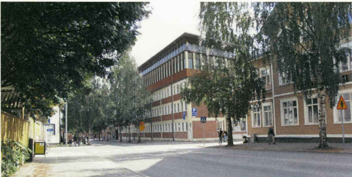
Vy längs Skolgatan mot det påbyggda huset.
