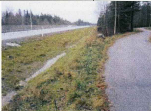
Figur 3. Dike vid väg E4.
