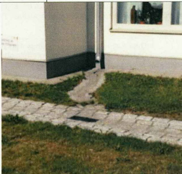
Figur 6. Utkastare med förstärkt infiltration.
