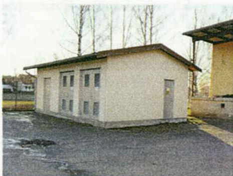
Transformatorstation på tomtens södra del (från 1995).
