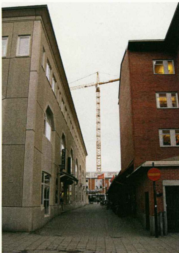
Tillbyggnad över gränden
