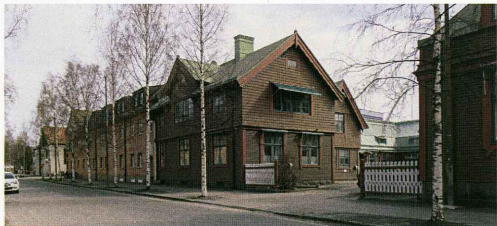
Vy från Döbelnsgratan efter tillbyggnad.
