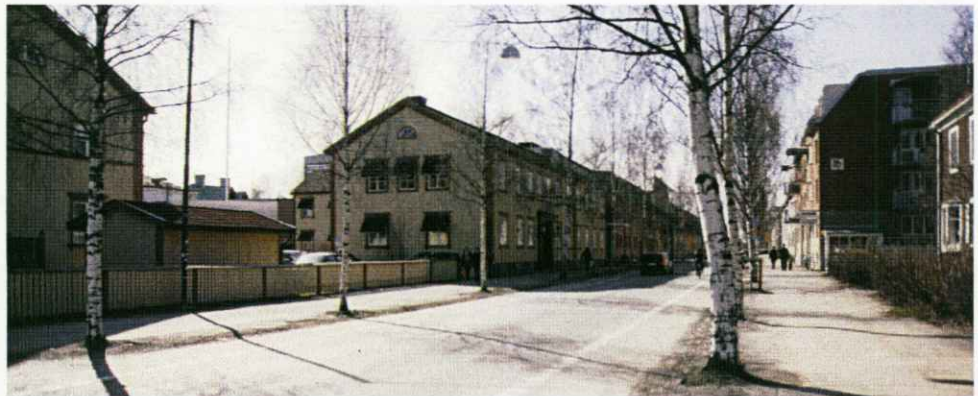
Vy längs Kungsgatan västerut efter tillbyggnad.
