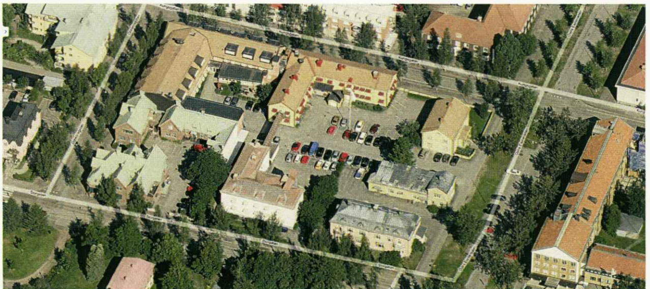
Kv Tyr innan rivningen av "Rosa huset" påbörjats.
