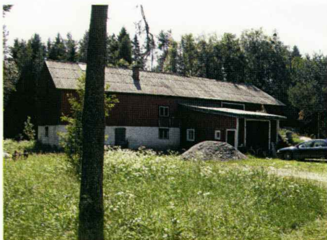
Äldre lagårdsbyggnad inom fastigheten 2:20.
