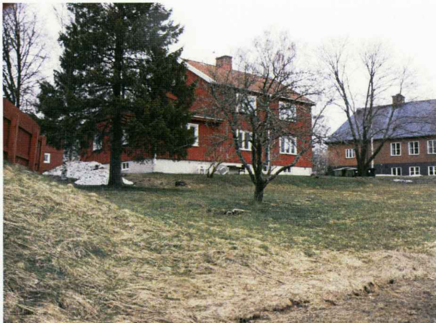
Baksidan av fastigheten Tavel sjö 6:29.
