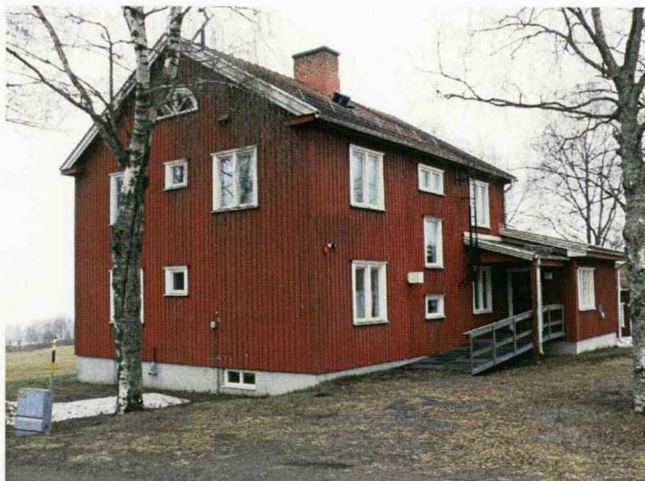
Tavelsjö 6:29 fasad vid entré från norr och gavel från öster.
