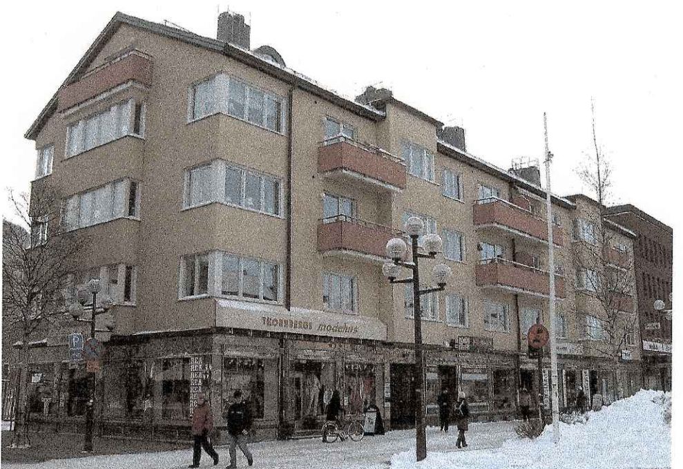
Tornbergska huset. Korsningen Rådhusplanaden-Skolgatan
