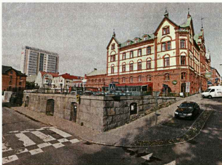
Kv. Heimdal med stenvuren och Stora hotellet sett från Västra Strandgatan.
