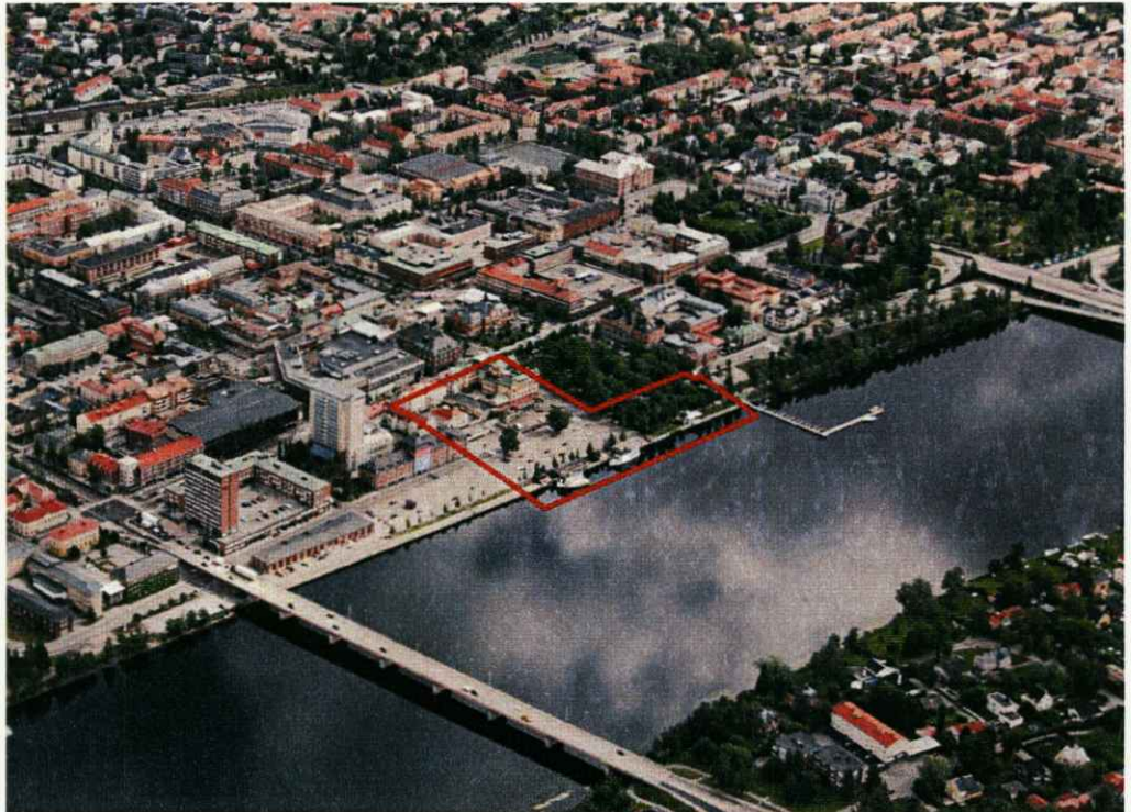
Flygbild över aktuell del av Umeå. Aktuellt planområde är markerat med röd gräns.
