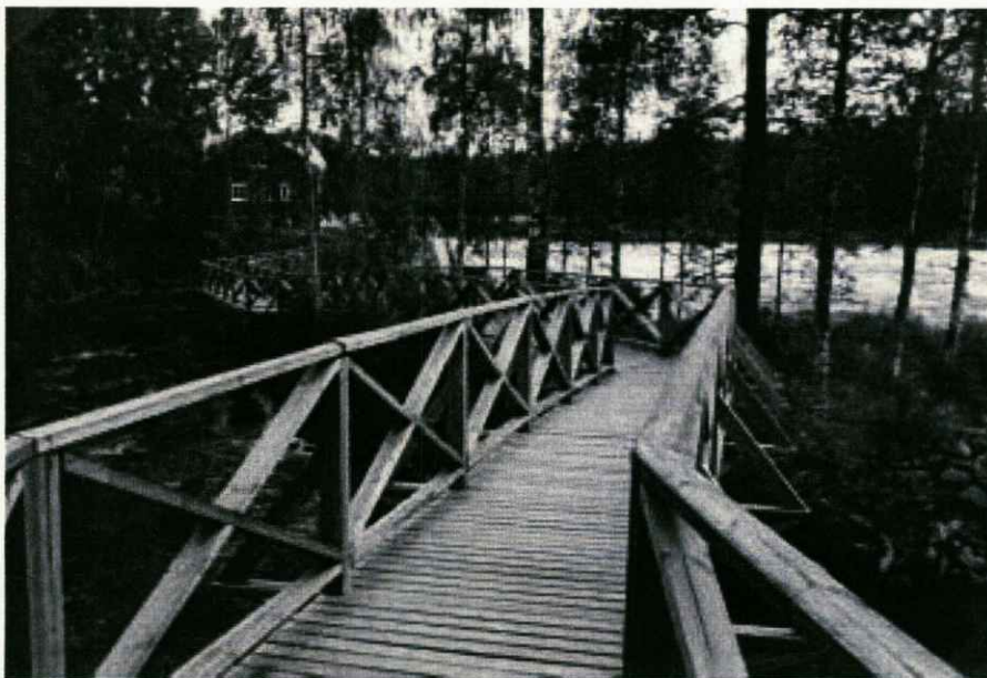
Fig. 6.6:1 En bra brokonstruktion.
