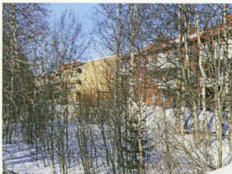
Kvarteret Fjällsippan vid Järnvägsgatan.
