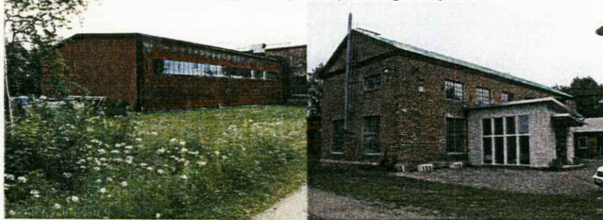
2. bilden t vänster: Tillbyggnad med lager från cykelvägen i nordväst.
