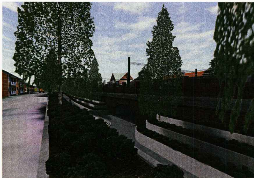
Exempel på utformning av bullerskydd mot Bangatan.
