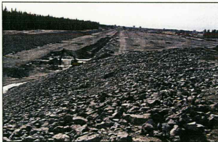
Pågående bygge av intilliggande ny godshangård.
