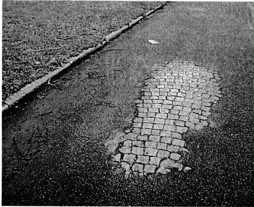
Hoppets gränd. Under asfaltytan ligger smågatsten.
