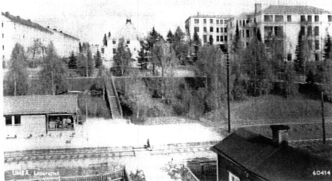
Järnväghållplatsen Öbacka, 1950-tal.
