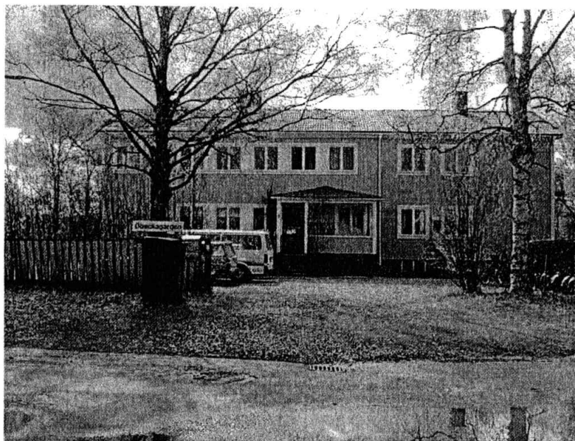
Barnhemmet 1. Gammalt barnhem som byggdes 1937. Tillbyggt 1946. Arkitekt Denis Sundberg. Nyttjas idag som behandlingshem under namnet Öbackagården. Byggnaden har ett kulturhistoriskt värde.
