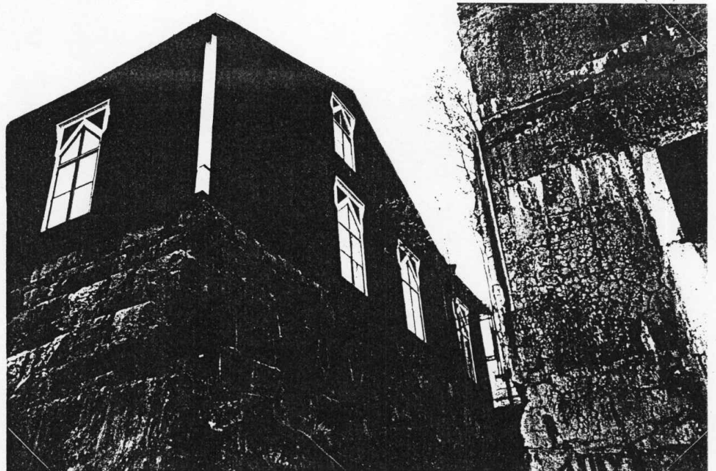
Detalj från norrfasad och fundament. (K5429:25)
