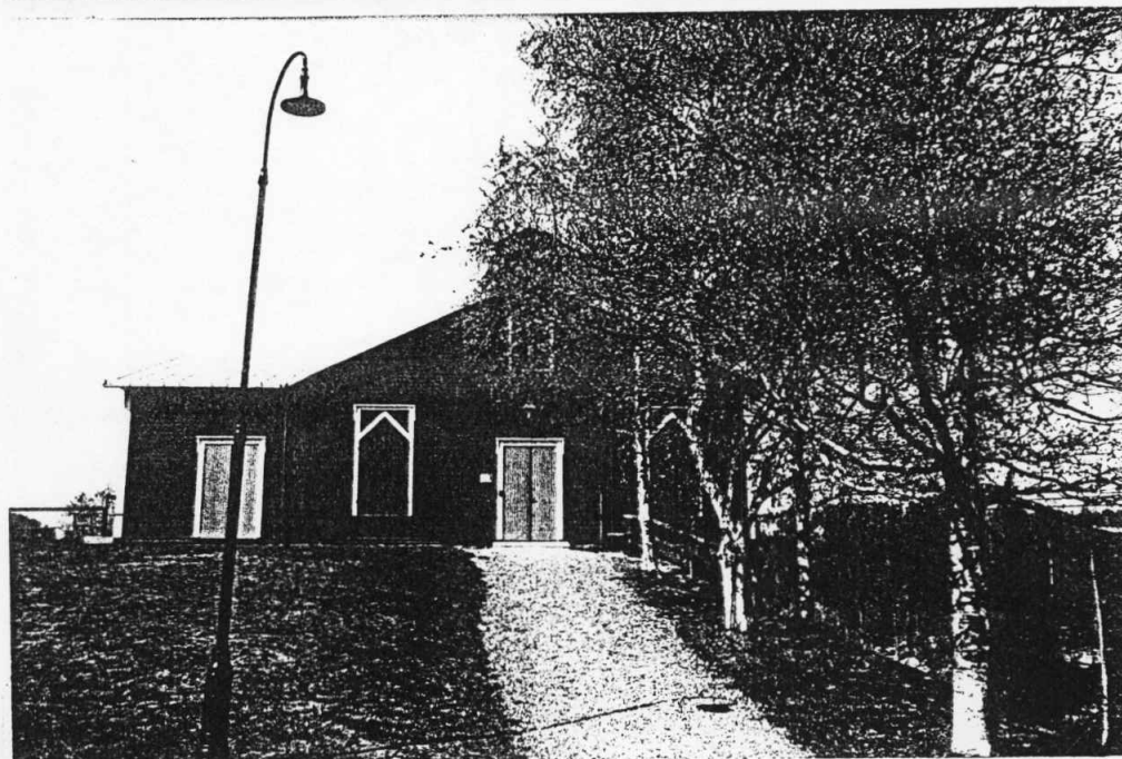
Sydfasad tillika entré till gamla kraftver- ket. (K5429:16)
