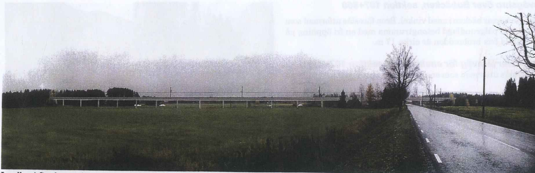
Landbro i Stöcke sett från väg 523 i riktning mot Ström.
