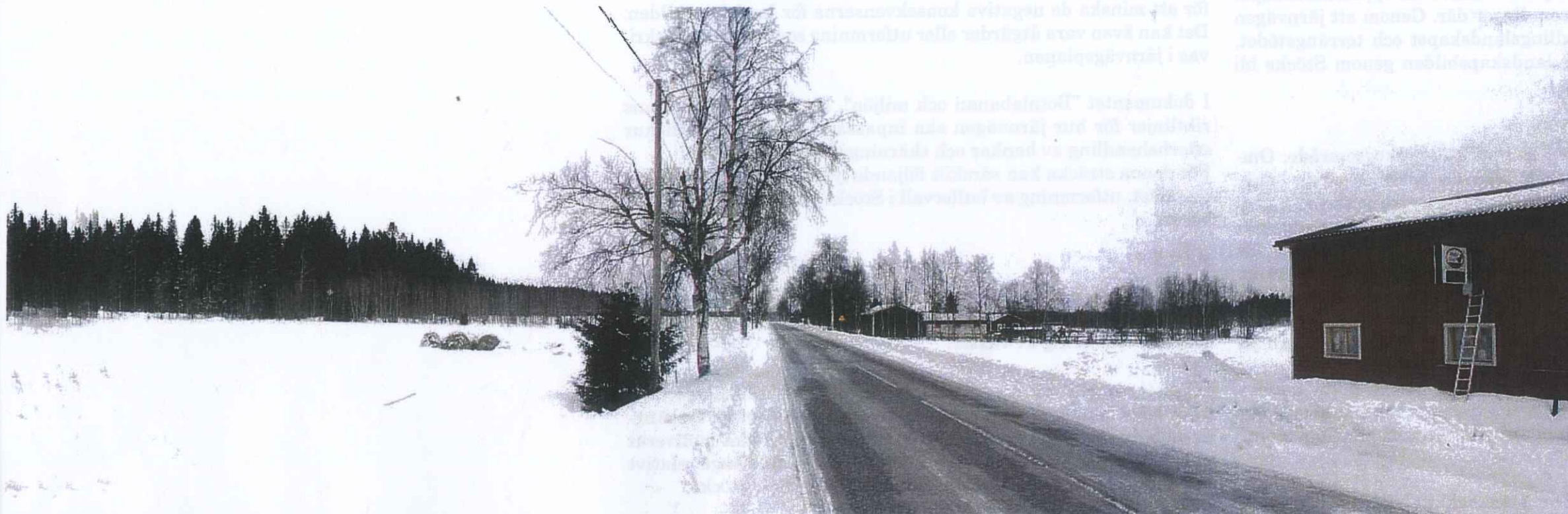
Stöcke. Vy mot norr från väg 523 utan Botniabanan.
