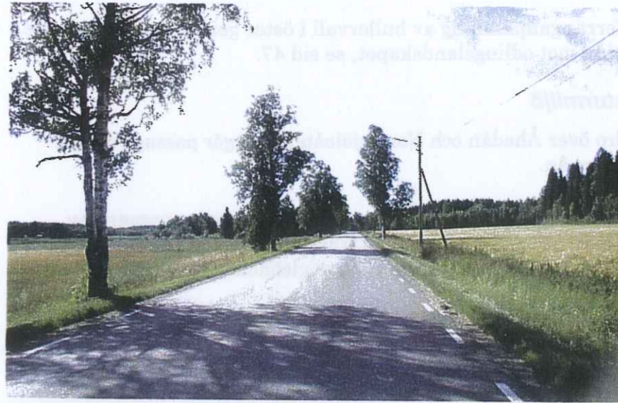
Väg 523 i Stöcke i riktning mot Ström
