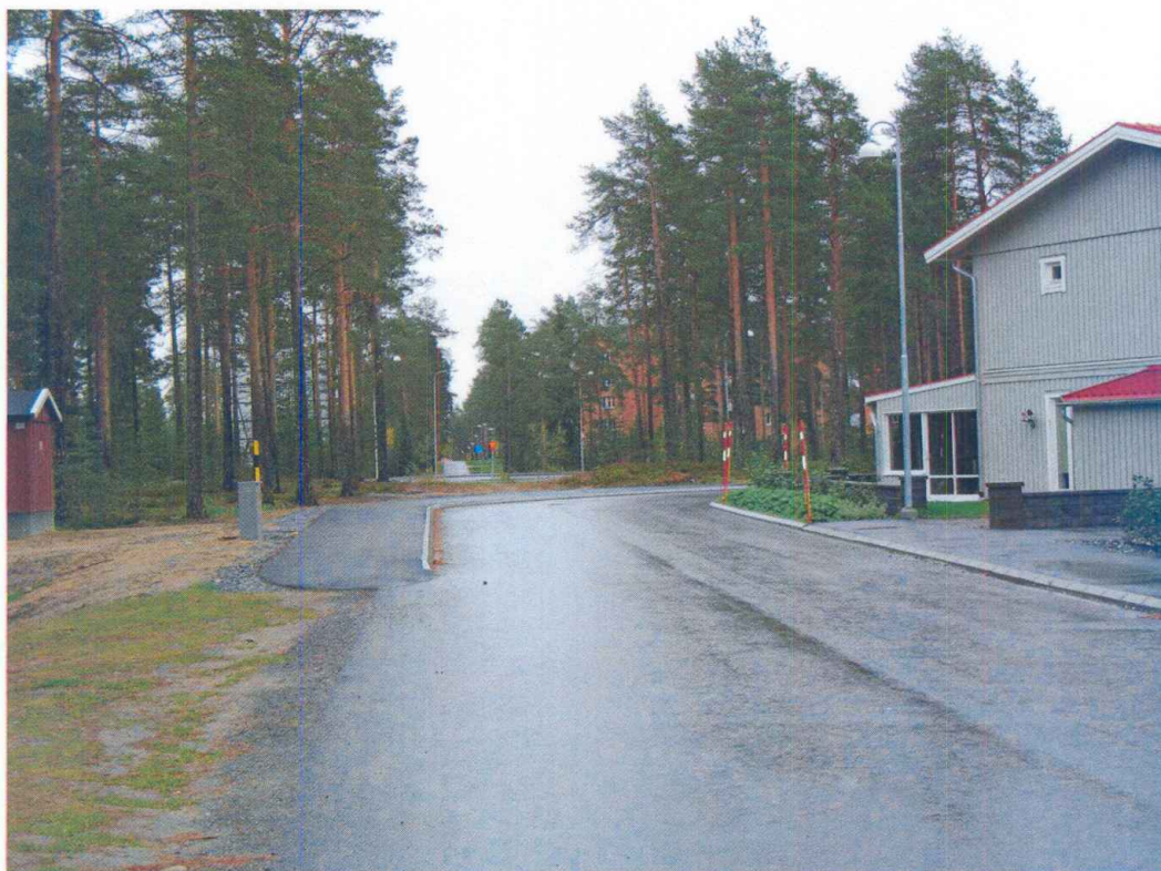
Honungsvägen österut där gångbanan idag byter sida.
