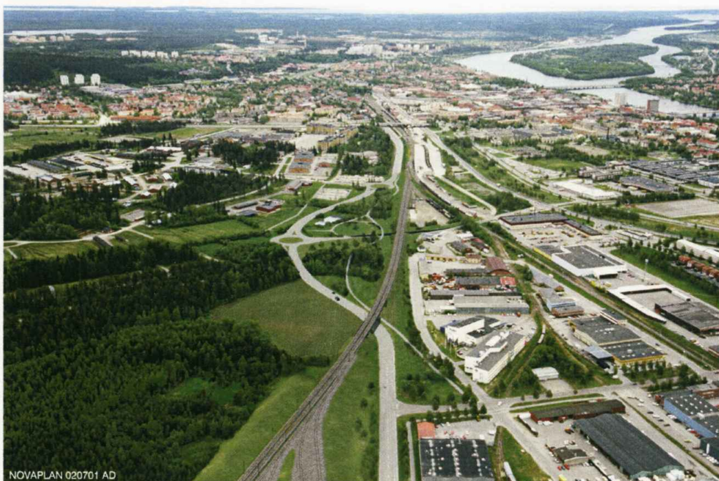
Flygbild över området med planerad järnväg och omläggning av vägar.
