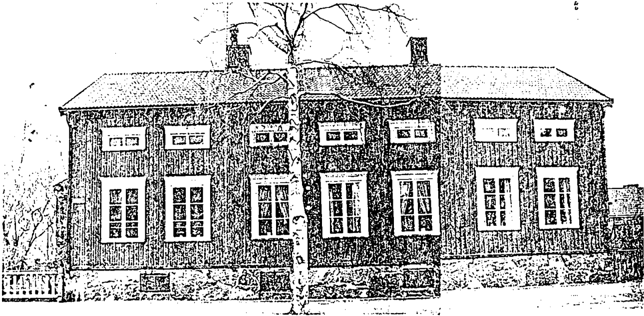
Byggnad 1 fasad mot Kungsgatan K 960:28-29
